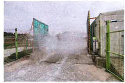
농장 출입구 차량소독시설
