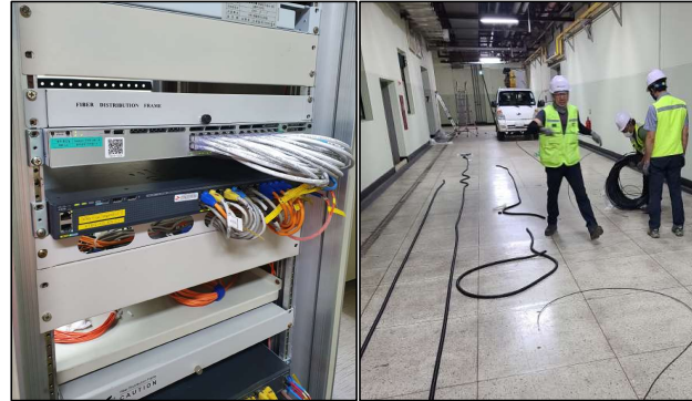
KT&amp;G 광주공장 광케이블 시공
