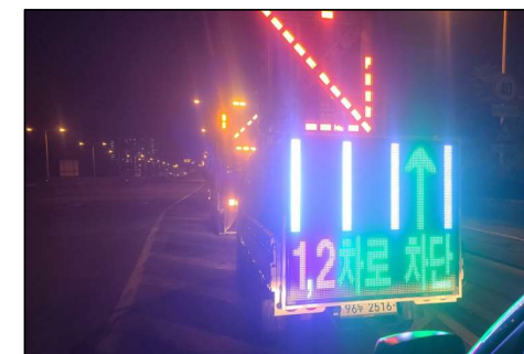
북부순환도로 야간 도로차단
