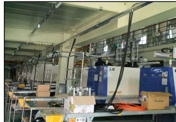
씨엠테크 네트워크 공사
