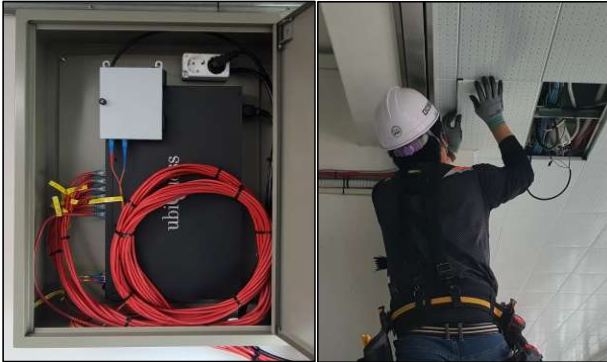
창평고등학교 광케이블 시공
