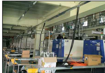
씨엠테크 네트워크 공사
