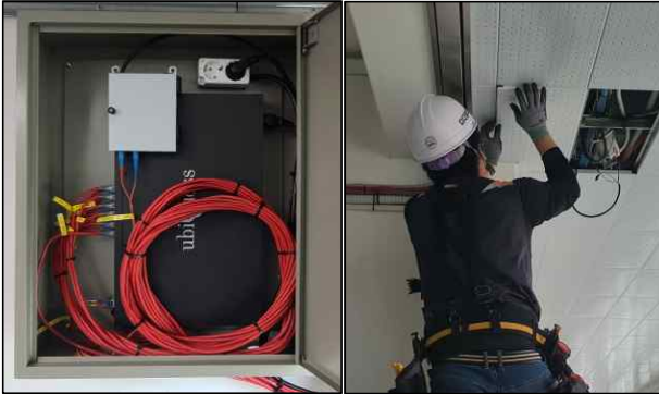
창평고등학교 광케이블 시공
