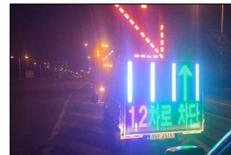
북부순환도로 야간 도로차단
